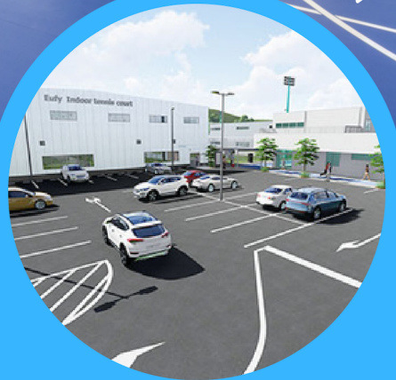
大型駐車場併設
